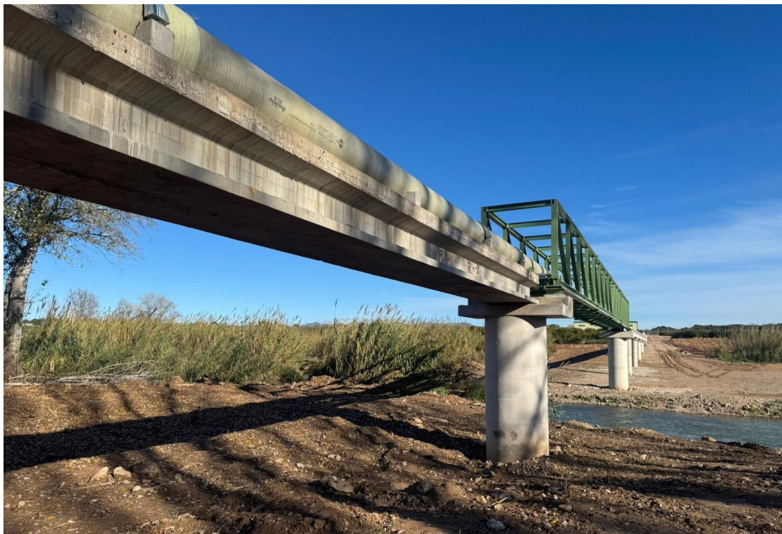
Finalizado el nuevo colector sobre el Turia tras quedar el original devastado por la danaLA RAZÓN
