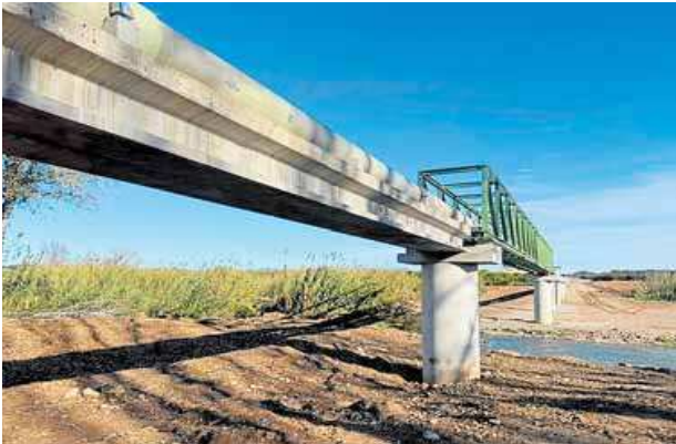
Imagen de la tubería reconstruida. LP
